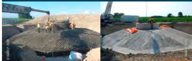
Fondations d'une éolienne de 2 MW
