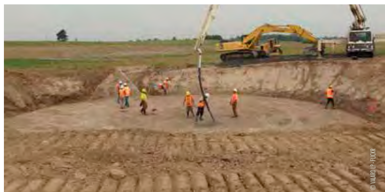
Fondations d'une éolienne de 2 MW
